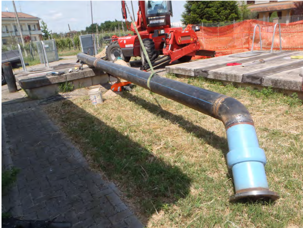
Nuovo tratto di Condotta dn 250 presso la Cabina Forlì
