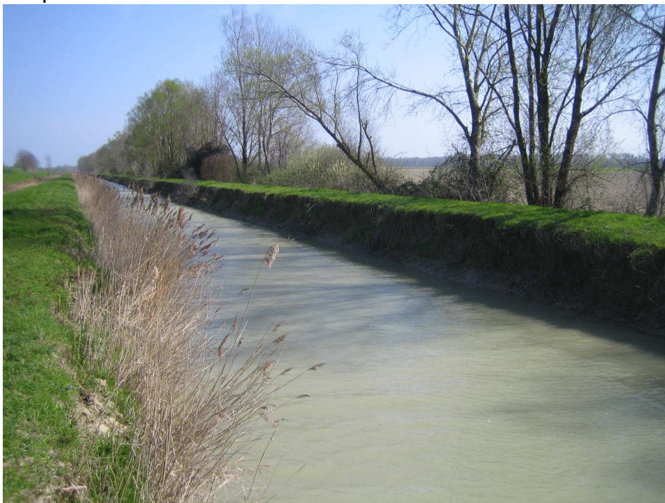
Foto prima dell'intervento
