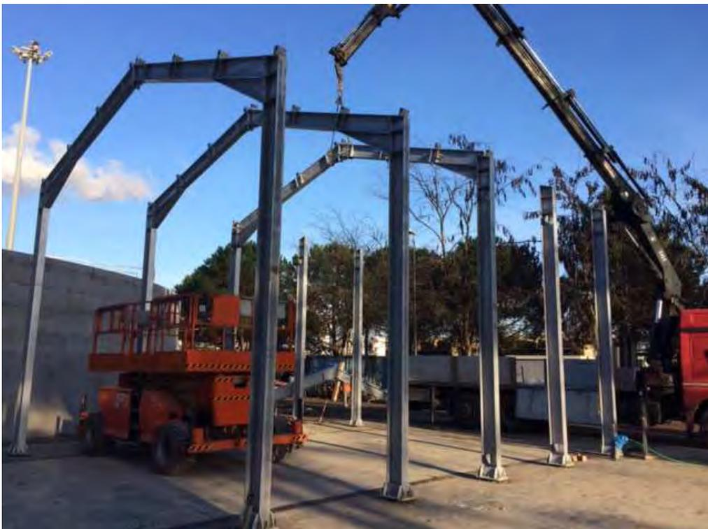
Montaggio tettoia su platea per alloggio centrifuga fanghi
