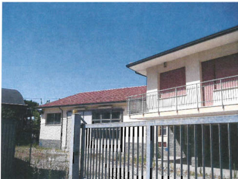
VISTA ESTERNA - EDIFICIO LABORATORIO ARTIGIANALE
