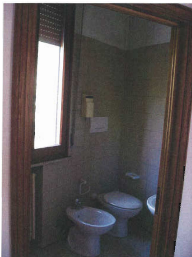
PUNTO DI VISTA F12 – INTERNO EDIFICIO UFFICI
