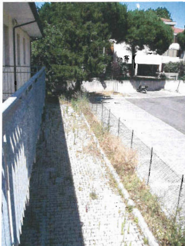
PUNTO DI VISTA F16 – EDIFICIO UFFICI
