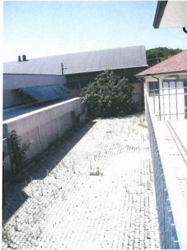
PUNTO DI VISTA F15 – EDIFICIO UFFICI
