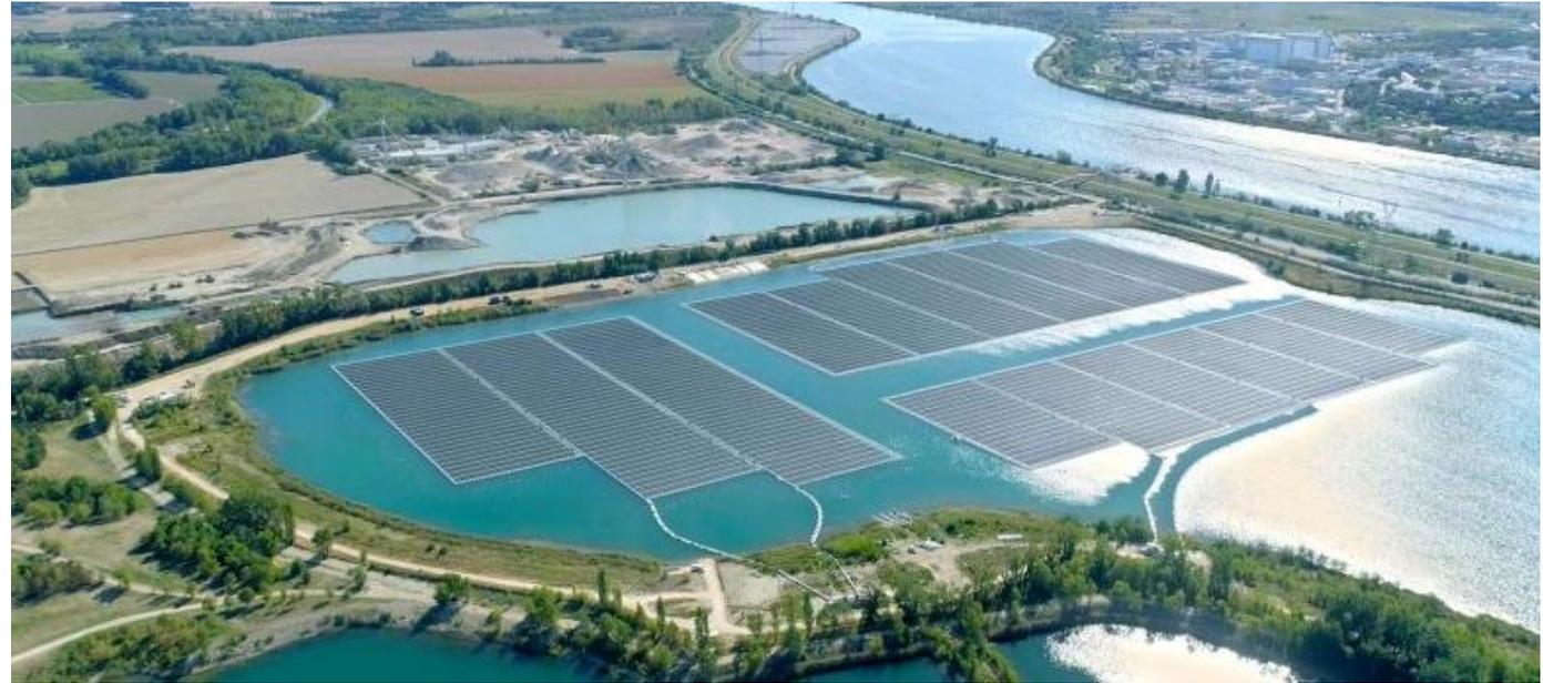
**Esempio di applicazione pratica di pannelli fotovoltaici flottanti nel distretto del Po da posizionare in: cave in disuso, bacini di raccolta acque per uso agricolo, bacini di controllo allagamenti, bacini di raccolta acque per uso industriale, etc**
