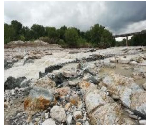
**MAGGIO 2019** – CON IL CROLLO DELLA TRAVERSA L'EROSIONE IN ALVEO MINACCIA DIRETTAMENTE IL PONTE SULLA S.P. «SANTARCANGIOLESE»
